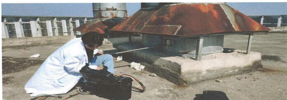
锅炉烟气排口 G 6
