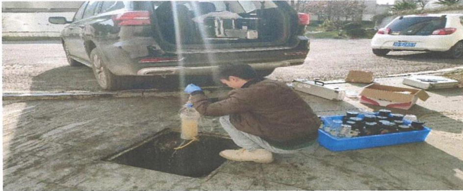
化粪池出水总排放口
