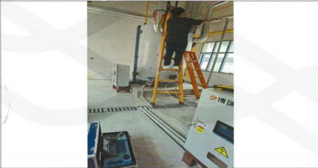
现场有组织废气采样图
