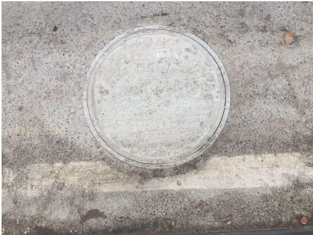
图 3-1 污水管网现场照片
