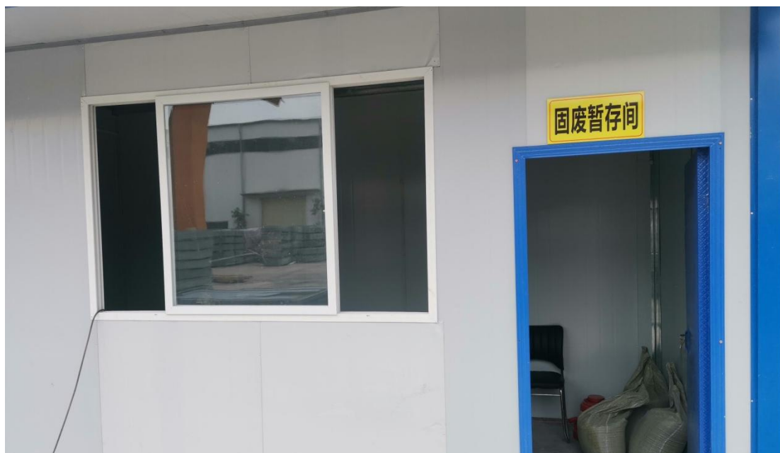
一般固废暂存间
