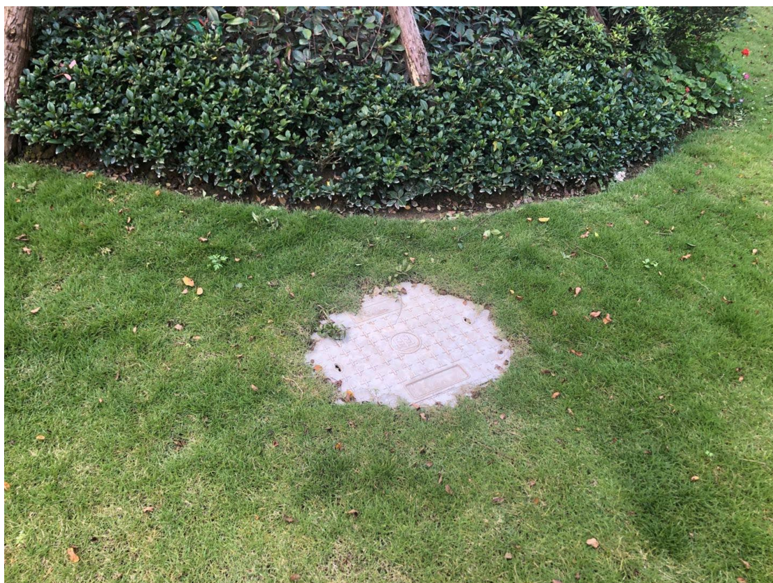
图 3-1 污水管网现场照片
